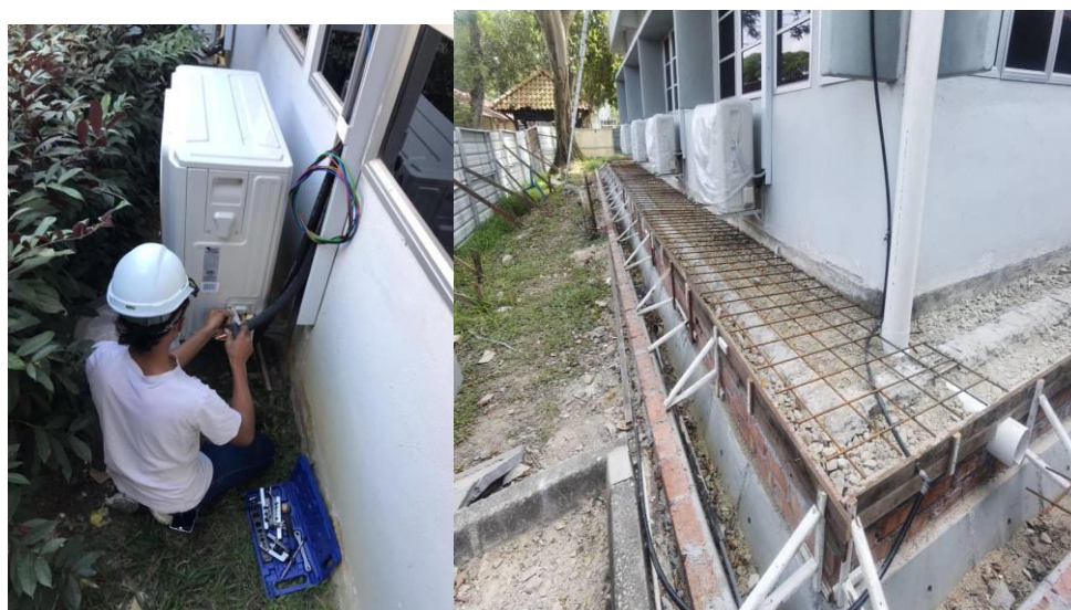
Gambar 2.1.1 : Kerja-kerja Menaiktaraf Infrastruktur yang sedang dijalankan
