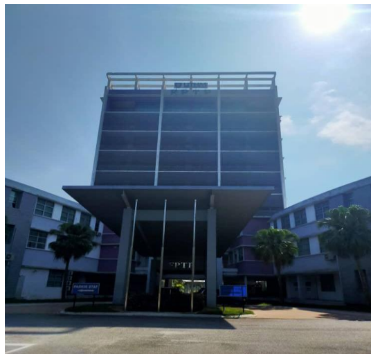
Gambar 2.3.3 : Kerja penstabilan struktur lantai di Blok FFTP
